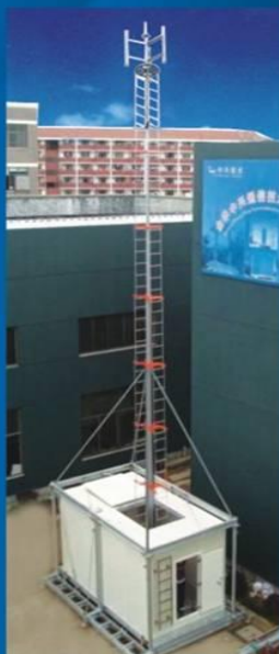
舱塔一体化集成舱安装完成
