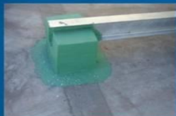
钢网基础锚固及防滑处理
